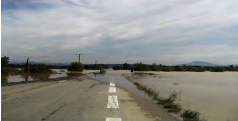
Inondation d'une route près de Rohegude
